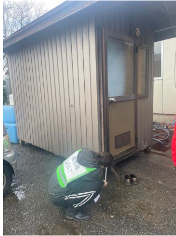
屋外浴室の段差調査
